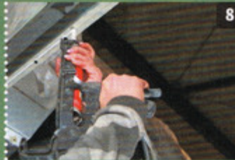
8 Eine feine Raupe Dichtmasse schützt das doppelte Blech
