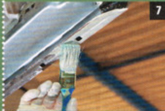
7 Eine sorgfältige Grundierung bietet die Basis für den Lackaufbau
