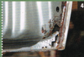
4 Die bröckelige Ecke würde ein Schweißen aufwendig machen
