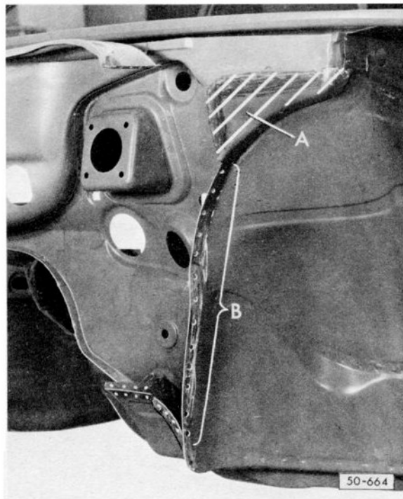
Bild 5: Radhaus Reststück abbohren
